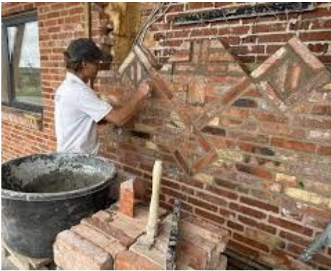
De gamle mursten bliver genbrugt og opsat i originalt mønster
